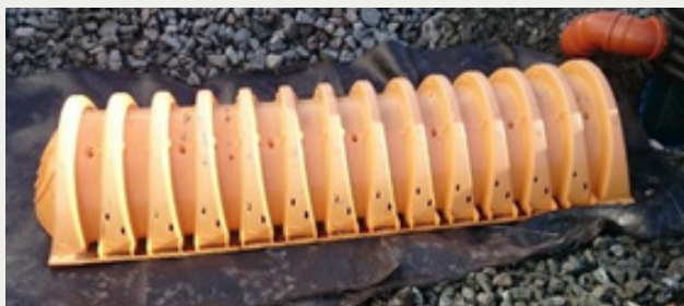
Dagvattentunnel under anläggningskedet som ansluts till styrbrunnen. Geotextilen hindrar att sediment når det öppna förstärkningslagret.
