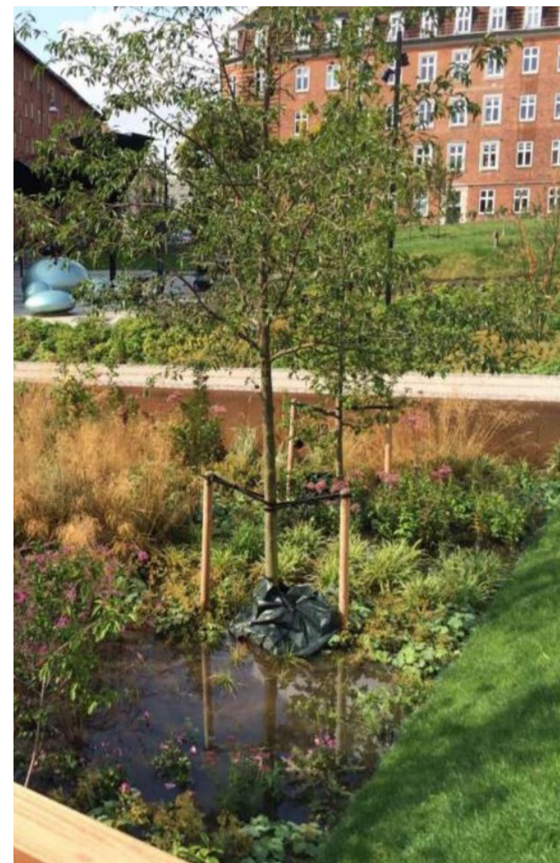
Inspektion av vattennivå efter kraftigt regn. Regnbädd, Tåsinge plads, Köpenhamn.
