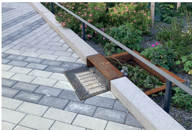
▲ Inloppsplatta, kantstödsöppning och sandfångskar. Amanuensgatan, Uppsala.
