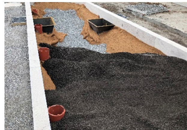
Utläggning av växtsubstrat på kokosmatta. Eksättravägen, Stockholm
