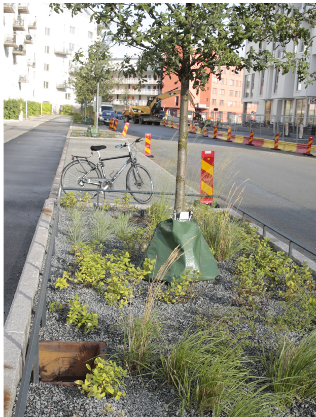
Regnbädd på öppet förstärkningslager, Torgny Segerstedts allé, Rosendal, Uppsala.
